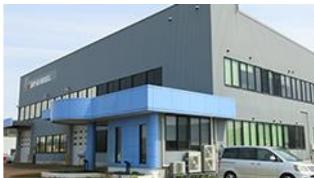
本社および工場外観
